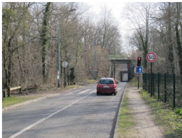
Vue sur la Route des Loges côté Achères au niveau du feu routier permettant de gérer l'alternance des flux de passage sous les deux ponts ferroviaires
