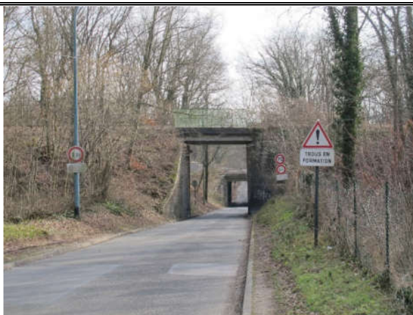
Vue sur la Route des Loges côté Achères au niveau du passage sous le pont de la Grande Ceinture
